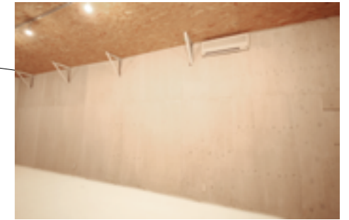
【展示エリア・左右壁面】 針葉樹合板ホワイトカラー。床はツヤあり白。 右壁面に分電盤、スイッチ、エアコンあり。
